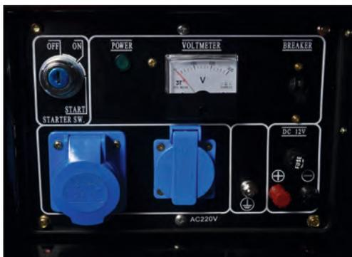
Anschlüsse: 1x 230V / 32 A (CEE), 1x 230 V / 16 A (Schuko)
